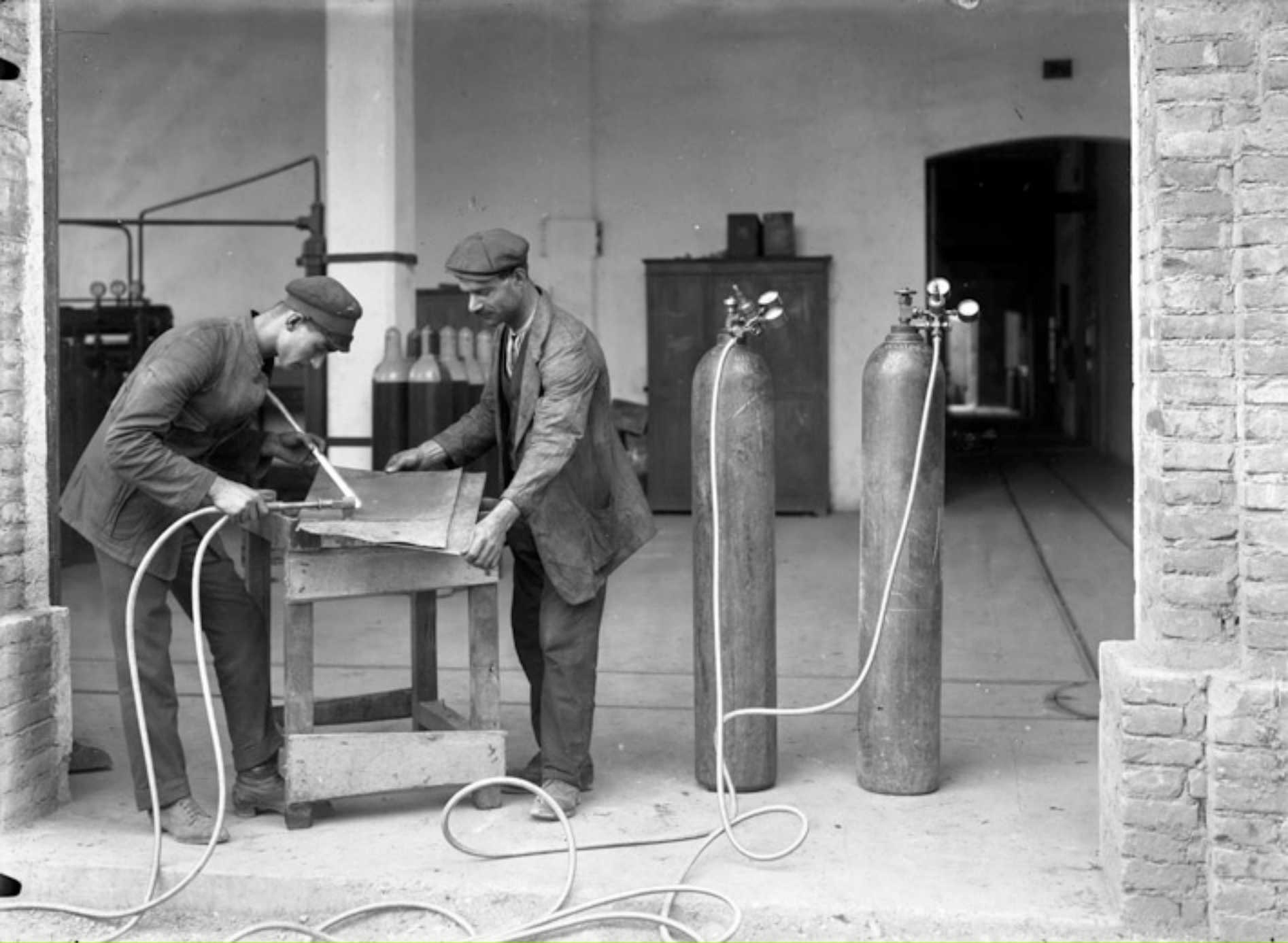
Saldatura. Stabilimento Elettrolitico Ansaldo, Genova Cornigliano, 1910 Fondazione Ansaldo, Genova
