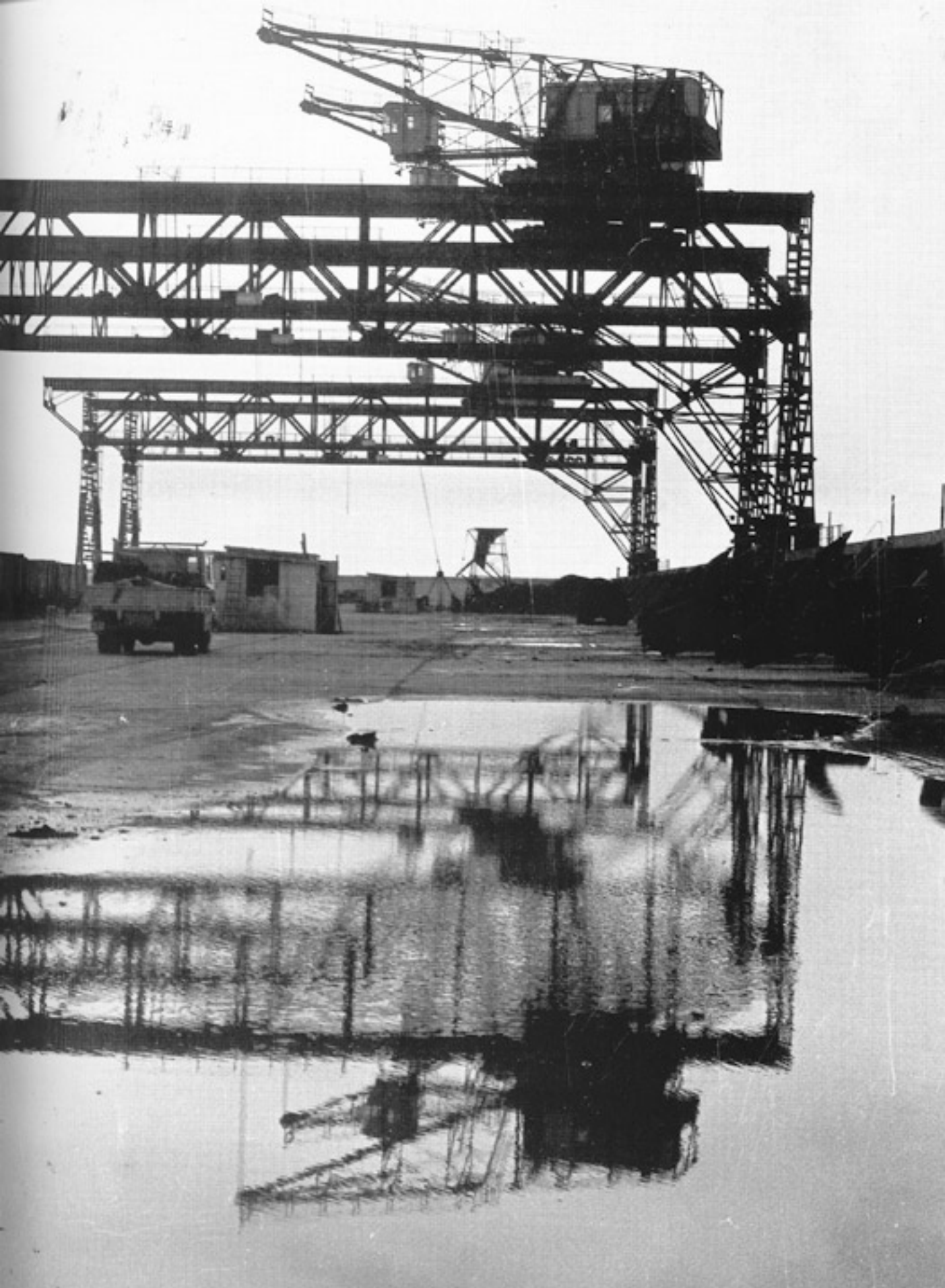
Elevatori Ansaldo IV tipo da 6 tonnellate nel ponte Rubattino. Genova, 1975 Archivio storico Autorità portuale di Genova, Genova
