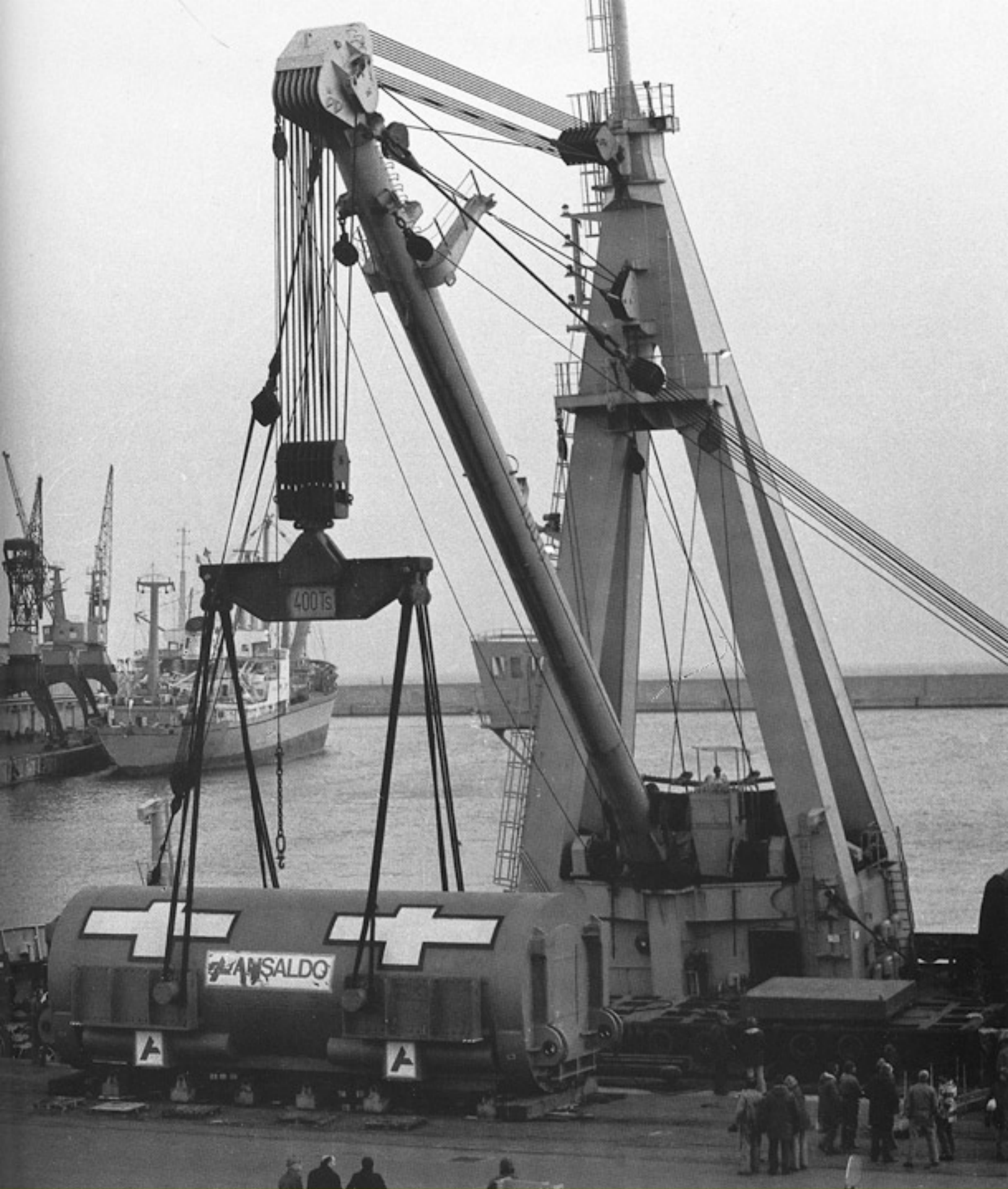
Imbarco turboalternatore Ansaldo sulla nave Gloria Virentium, Calata Massaua. Genova, 1981 Archivio storico Autorità portuale di Genova, Genova
