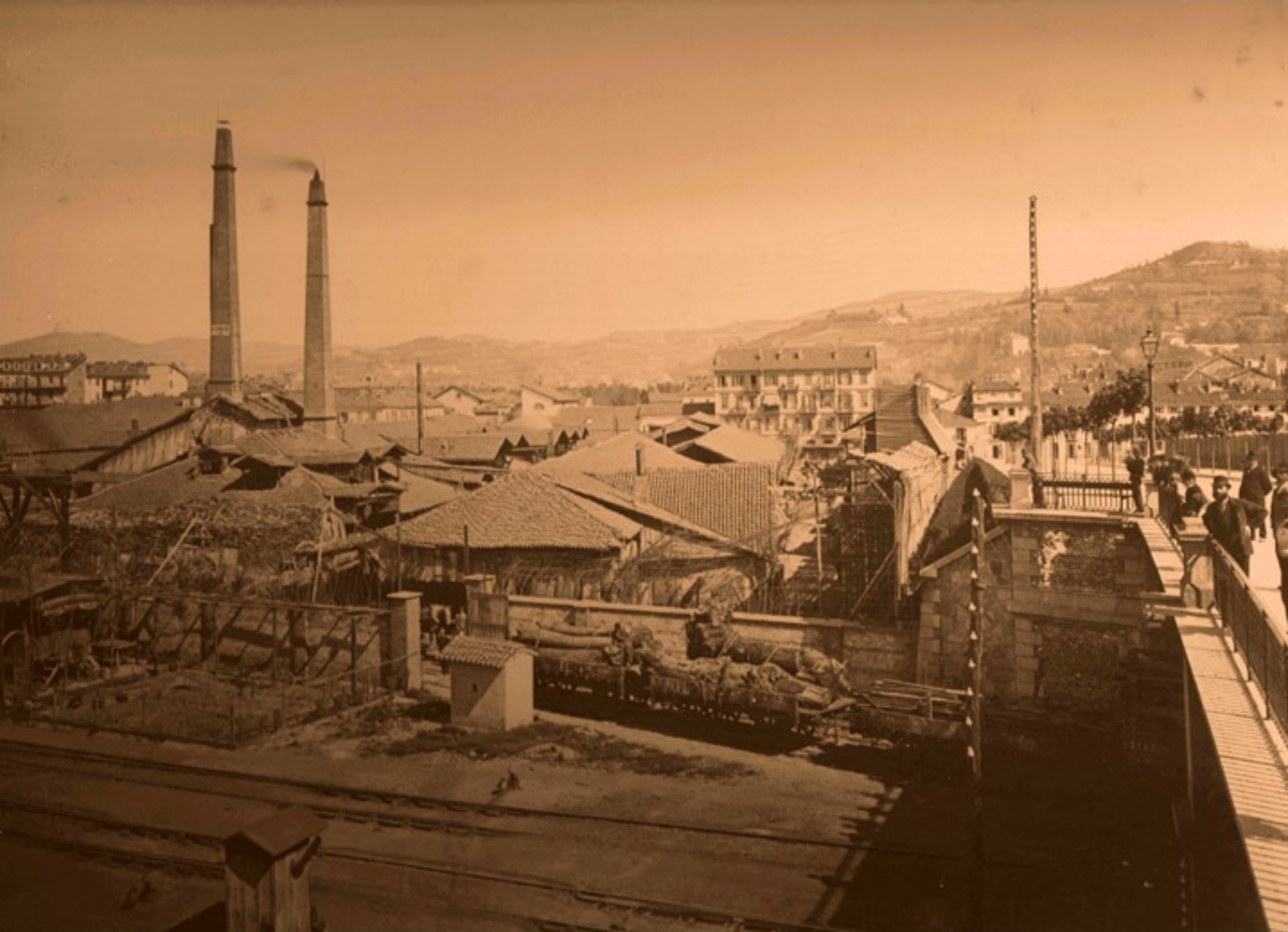
Raccordo ferroviario collegato alla Fabbrica Legnami Ferrato visto dal cavalcavia di c.so Sommeiller. Torino, 1882 Collezione privata Marco Ferrato, Torino
