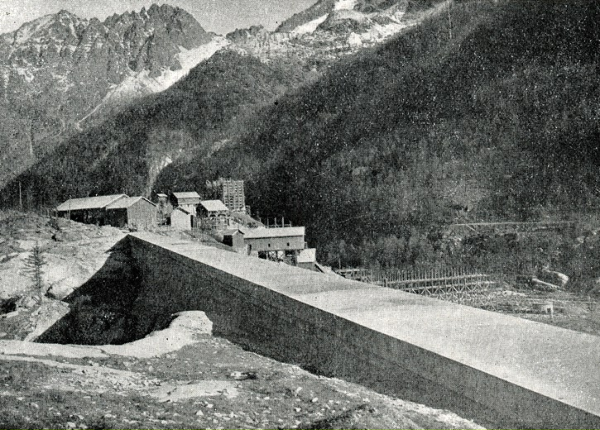
La diga minore compiuta. Nello sfondo il cantiere per la grande diga. Ceresole Reale (TO), anni '20 Archivio Storico della Città di Torino - Tratto da Rivista Torino 1928 n.1
